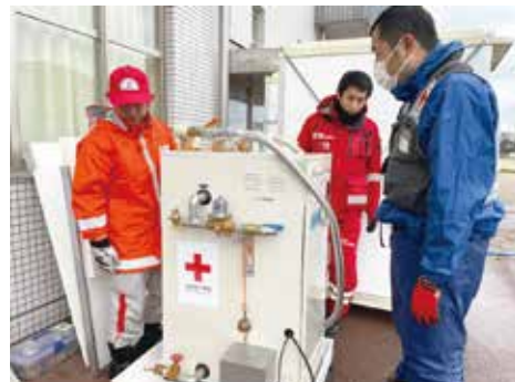
給水支援の資機材を設置する日赤職員 (石川県七尾市)
