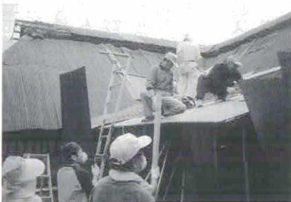
屋根の雨漏り修理と風呂場新築工事
